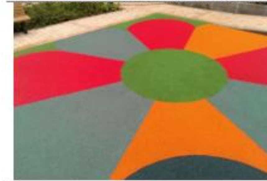
Цветное полимерное покрытие на асфальте
